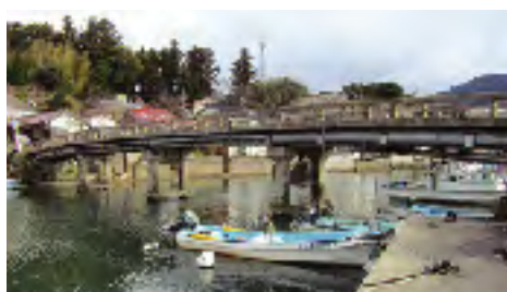
復旧が待たれる愛の橋
