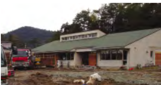
工事中の仁万の里
