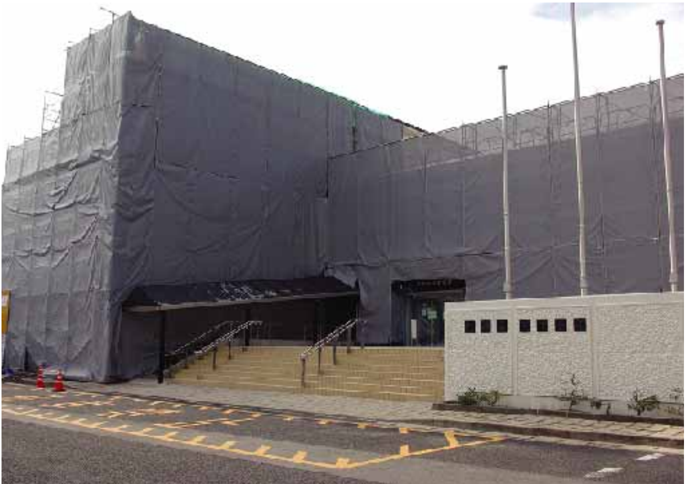
工事が進む隠岐島文化会館
