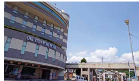
2F壁面の開口予定のホテルと撤去予定のスカイブリッジ
