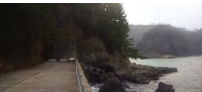
土木遺産の旧福浦トンネル
