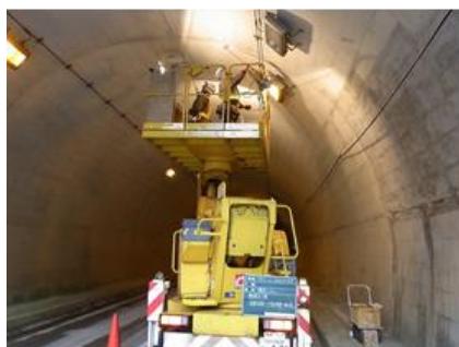
写真 2-1 トンネル点検状況
