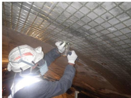
写真 3-1 FRP ネット設置状況
