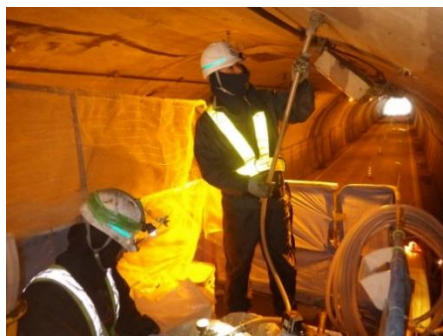
裏込注入状況
