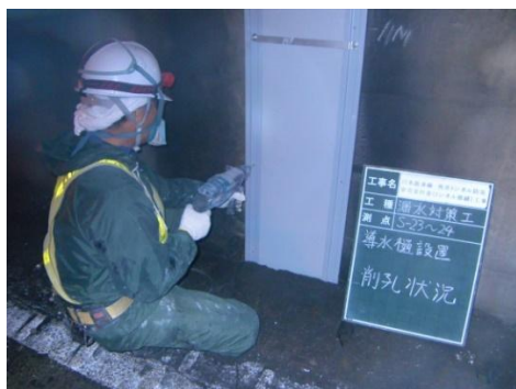
写真 3-2 線導水工
