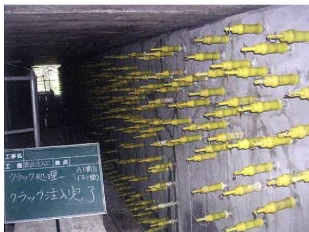
写真3： ひび割れ注入状況
