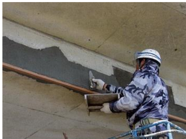
写真2： 断面修復状況
