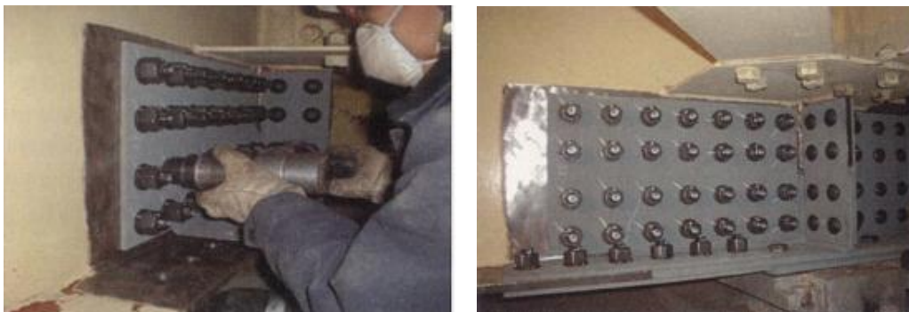
写真1： 当て板工実施状況
