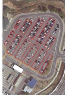
隠岐病院 カーポート型太陽光
