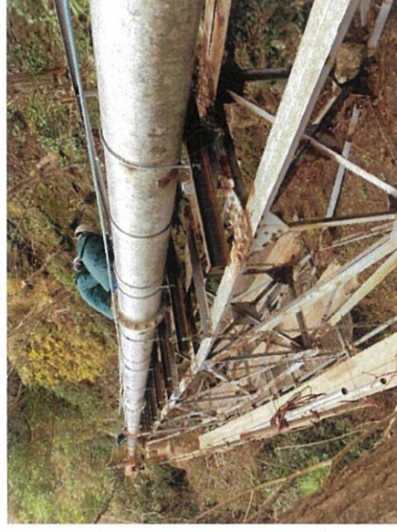
水圧鉄管撤去、水路橋補強
