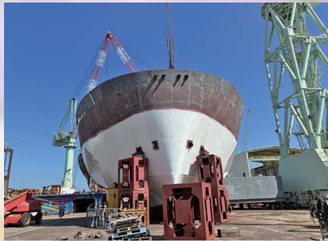
▲令和9年春頃の就航に向け、建造が進むフェリーしげさ（10月時点）
