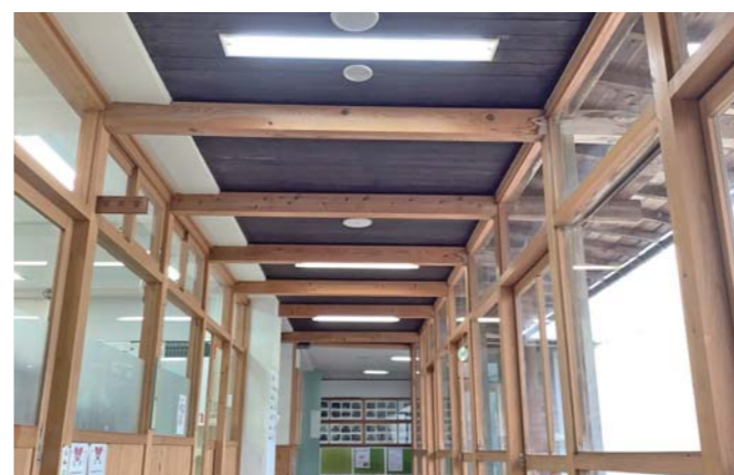
▲LED照明化する予定の都万小学校校舎
