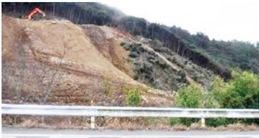
飯田残土処理場
