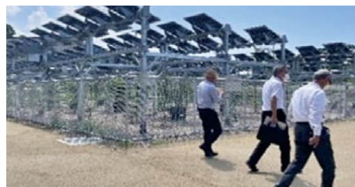
太陽光発電施設
