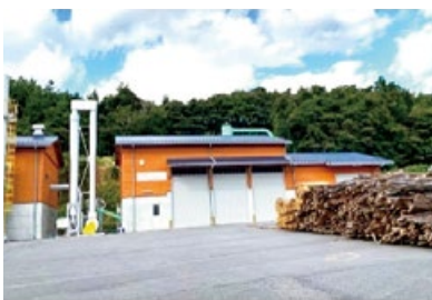
本格的な稼働が始まるペレット製造施設
