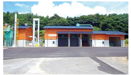
木質ペレット製造施設
