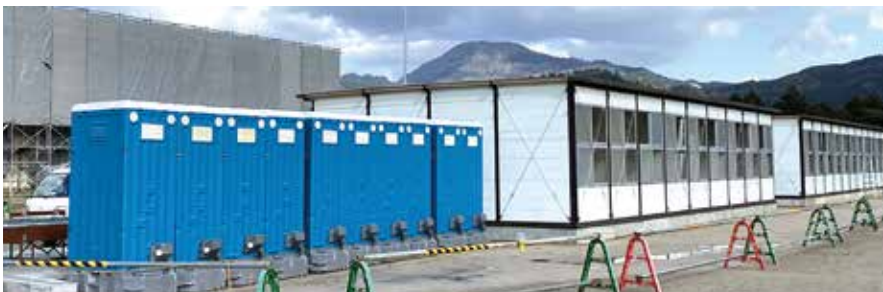
工事中の仮校舎
