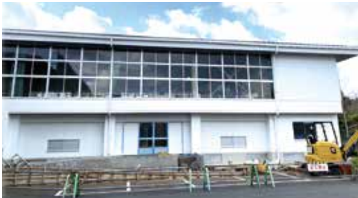
改修工事完了間近の体育館
