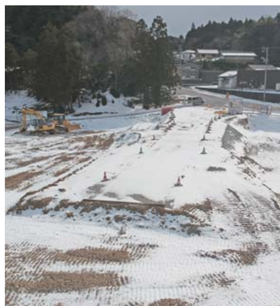
造成工事中新庁舎予定地
