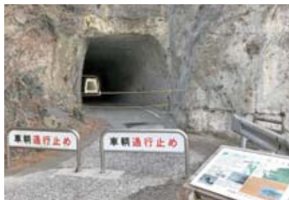
急がれる安全対策
