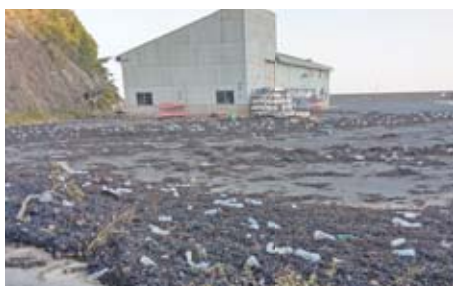
台風被害のあったヨット艇庫
