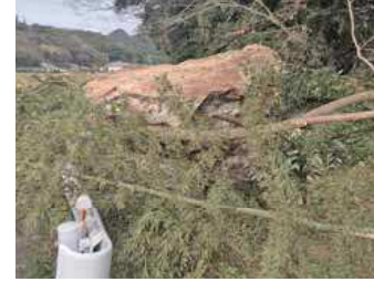
都万地区で発生した落石の様子
