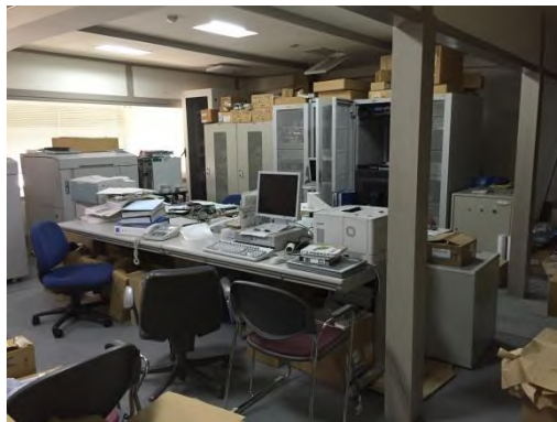
会議室を改造したサーバー室
