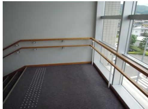
手摺り・点字ブロックの設置された階段（真庭市）
