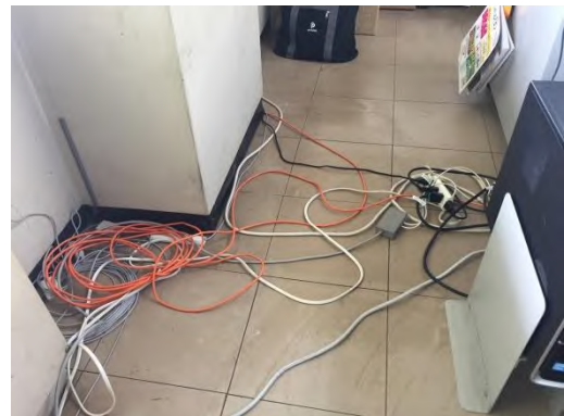
配線が露出しているフロア
