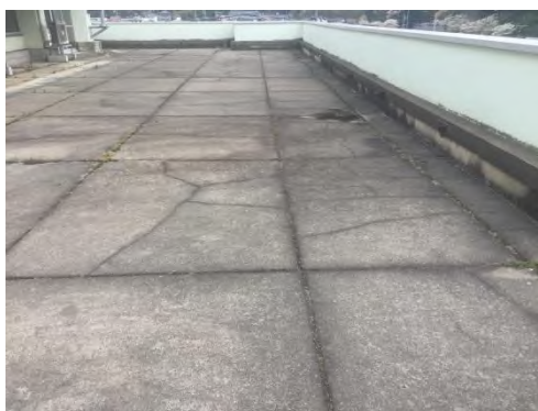
老朽化した屋上
