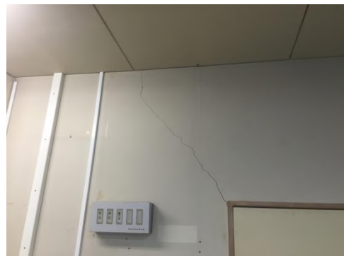
壁に入ったクラック
