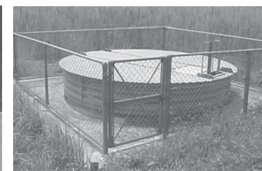
地すべり防止施設 （集水井工）上那久地区
