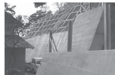
急傾斜地崩壊防止施設 （擁壁工、法砕工）釜屋地区
