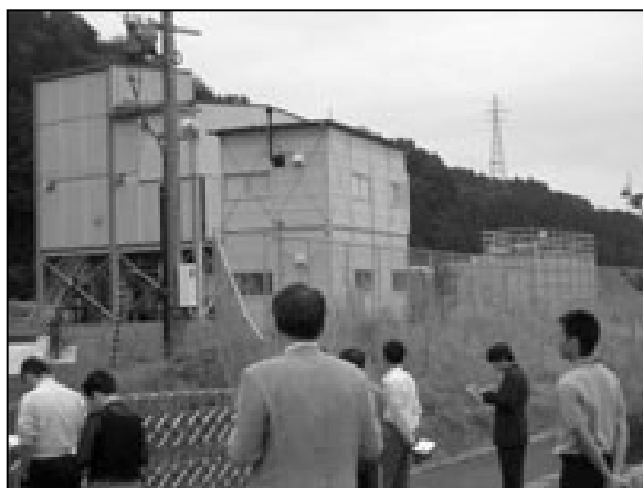
▲三井造船エタノールプラント
