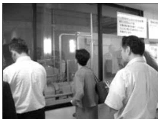
▲蒸気タービン発電設備
