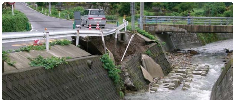
急がれる災害復旧工事
