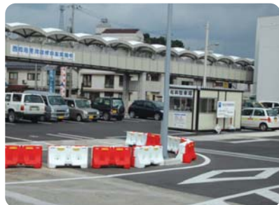
完成した西郷岸壁の駐車場
