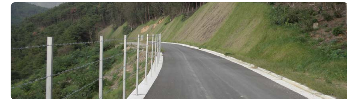
完成した蛸木地区の迂回路
