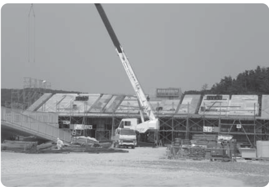
工事は進むが財政面では
