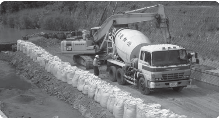
災害復旧工事
