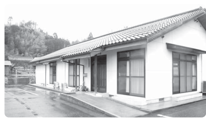
補助対象の枠を望む（グループホーム）
