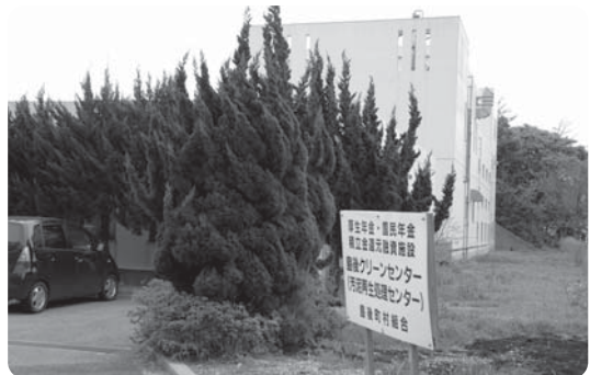
20年経過のクリーンセンター
