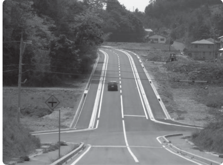
完成した塩口宮田線 くんだ
