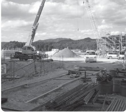
工事中の浄化センター
