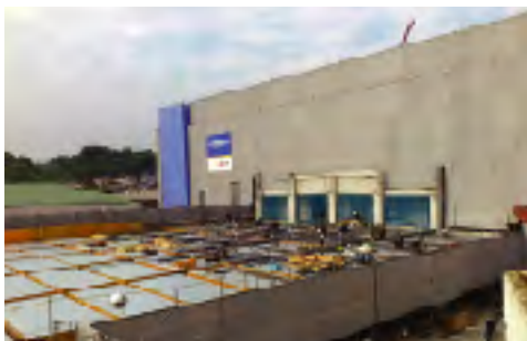
着々と工事が進む 新隠岐病院。
