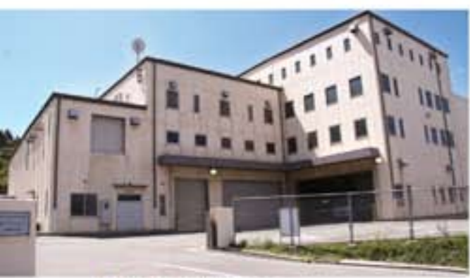
● 島後リサイクルセンター 廃棄物循環型社会の実現に向け、ごみの排出抑制・ 再資源化に取り組んでいます。
