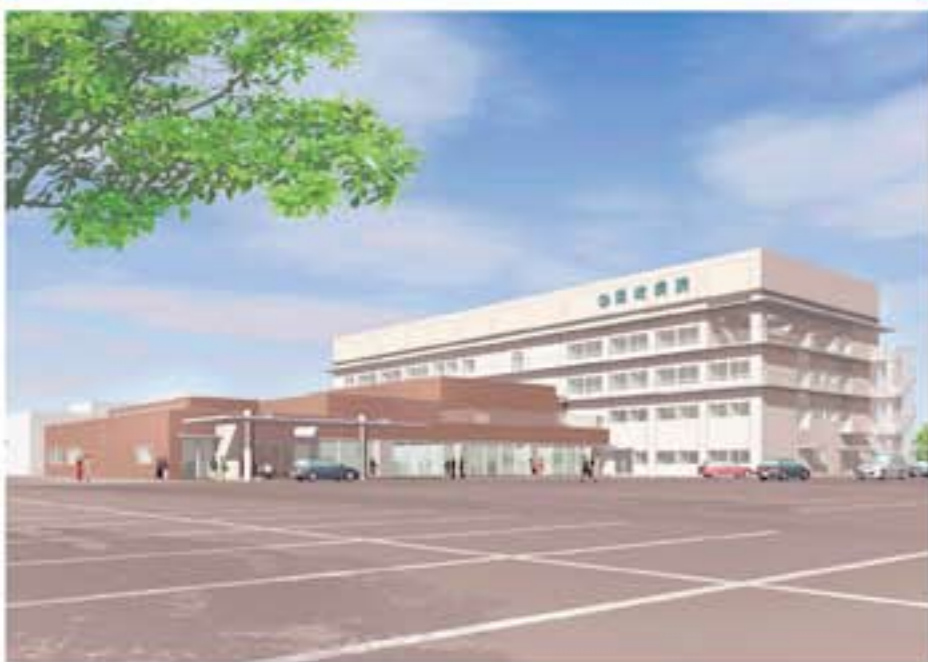
周辺環境と一体となった新しい隠岐病院 平成24年開院
