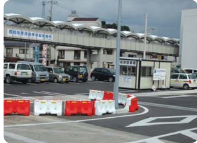
完成した西郷岸壁の駐車場
