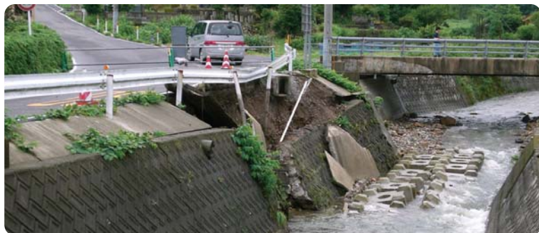
急がれる災害復旧工事
