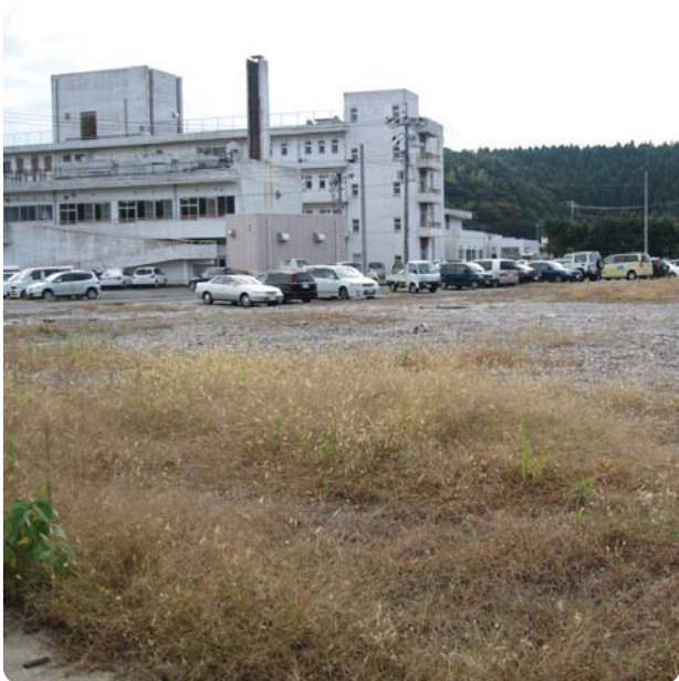
新隠岐病院建設予定地
